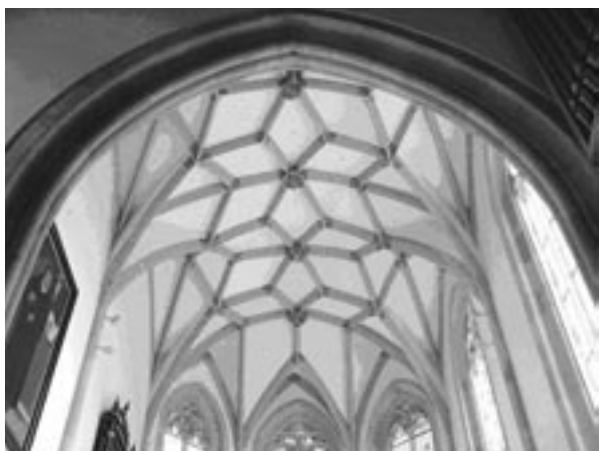
Der netzrippengewölbte Chor mit seinen vier Schlusssteinen
