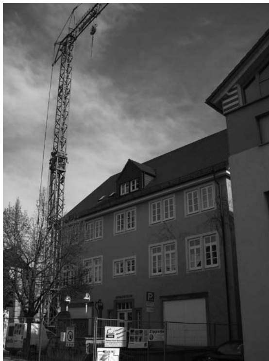
Der große Kran für den Fahrstuhlbau
