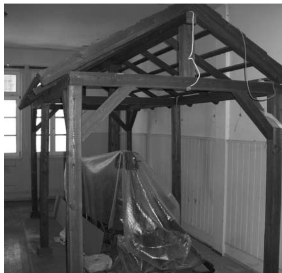
Blick in die Seilerei während der Bauzeit
