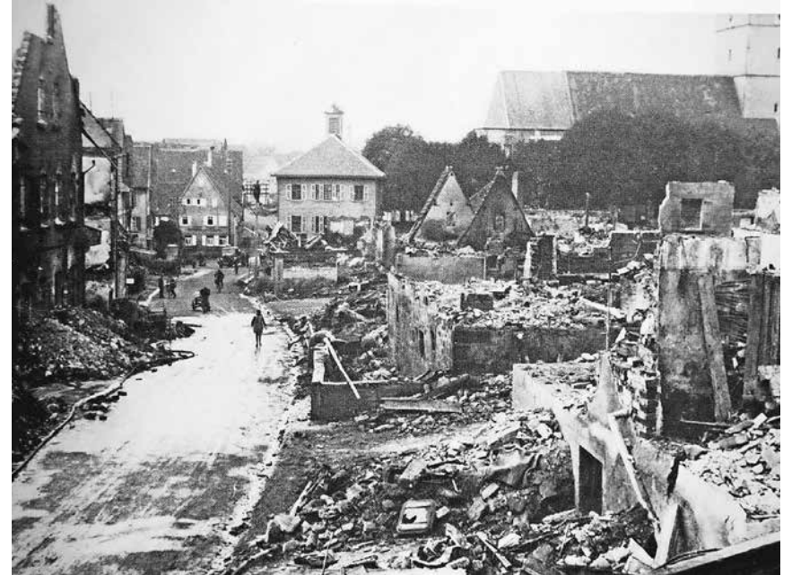
Das 1833/34 erbaute Rathaus wurde am 3. Mai 1945 angezündet
